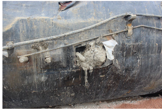
6(d) Bottom outlet valve
