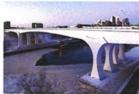
New I-35W Bridge, MN MnDOT
