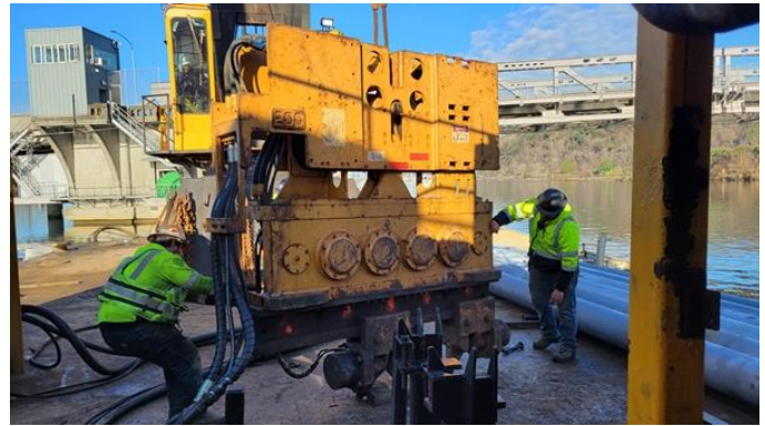
103. Fitting APE200 Vibro Hammer
