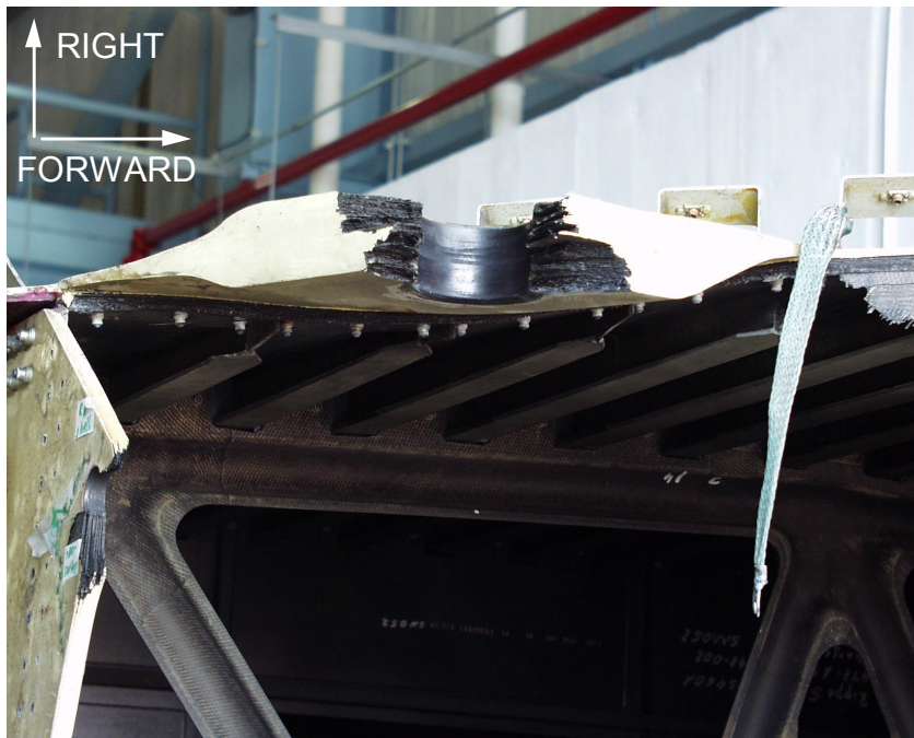
ImageNo: 208A0230, Project No:A00386
