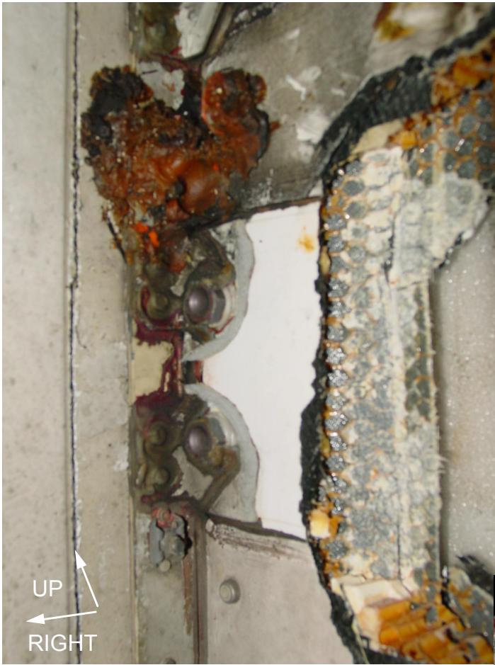
ImageNo:208A0305, Project No:A00386
