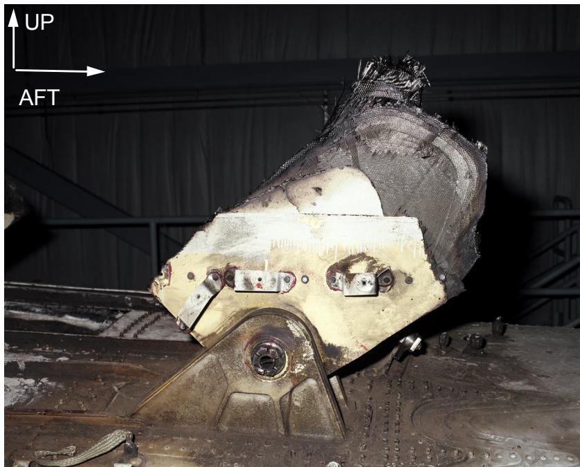
ImageNo: 208A0256, Project No:A00386
